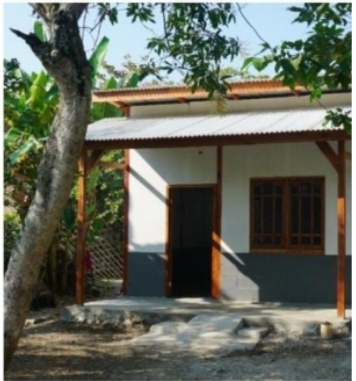
Kondisi rumah Maghfiroh setelah direhab Satgas
